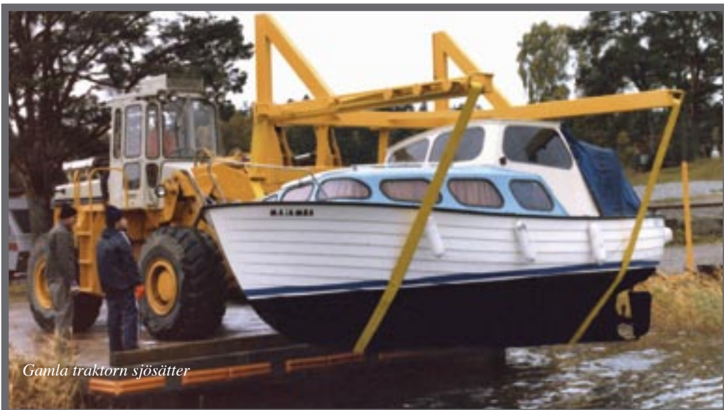
Sjösättningskajen under byggnation
