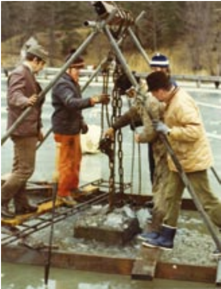
Lägger i betongklumpar till nya bryggan (observera strikta medlemmar i hatt)
