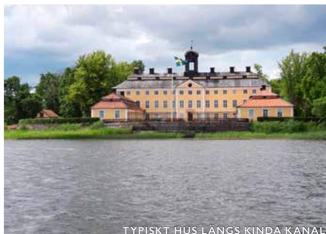
TYPISKT HUS LÄNGS KINDA KANAL
